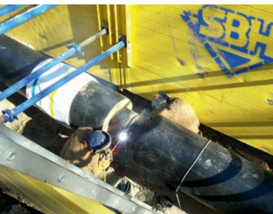
Abb. 2 – Die Kunststoffmantelrohre werden in den Verbau eingefädelt und dann verschweißt. Die Schweißnähte werden zerstörungsfrei geprüft (RT, VT, Vakuumprüfung).
